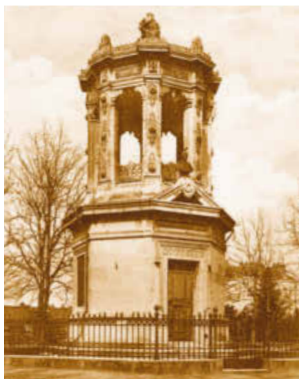
Château d'eau, place Darcy.
